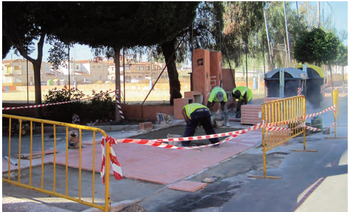
Los operarios trabajan reparando la acera que da acceso al parking de la Casa de la Cultura "Pedro Serna".
