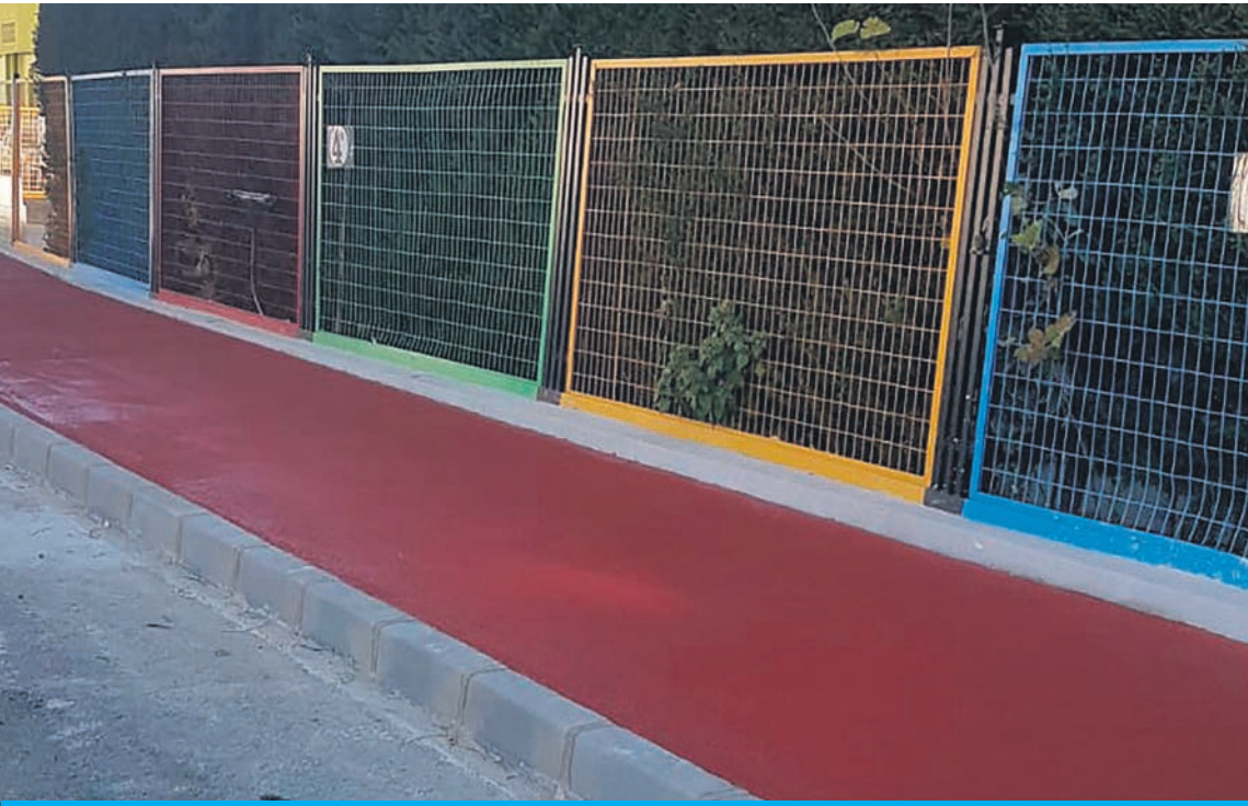
La nueva acera frente al centro solucionará los problemas que se creaban los días de lluvia y regulará el aparcamiento.
