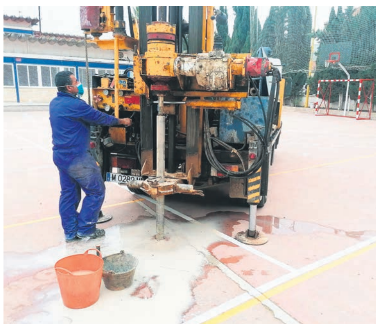
Los estudios geotécnicos, primer paso para elaborar estos proyectos.
