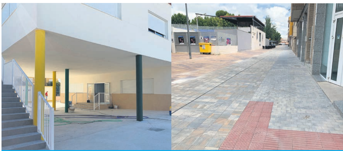
A la izq., obra del colegio San José. A la dcha., los trabajos del entorno de la calle Bartolomé Ródenas.
